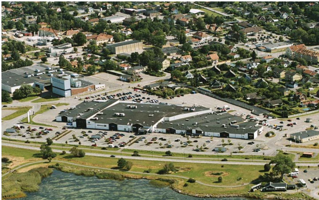
Storskalig bebyggelse norr om Storgatan. Flygfoto, Ölands Köpstad.
