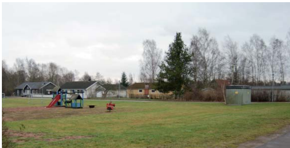
Transformatorstationen Idyllen och lekplatsen vid Musselvägen
